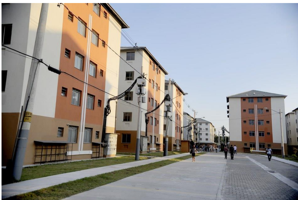
Figura 8 - Empreendimento do Minha Casa Minha Vida em Porto Velho – RO. Foto: Fernando Frazão
