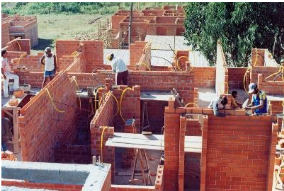
Figura 7 - Construção (1991-1998) por meio de mutirão gerido pela própria comunidade, com auxílio de mão-de-obra assalariada de apoio. Fonte: Usina CTAH.
