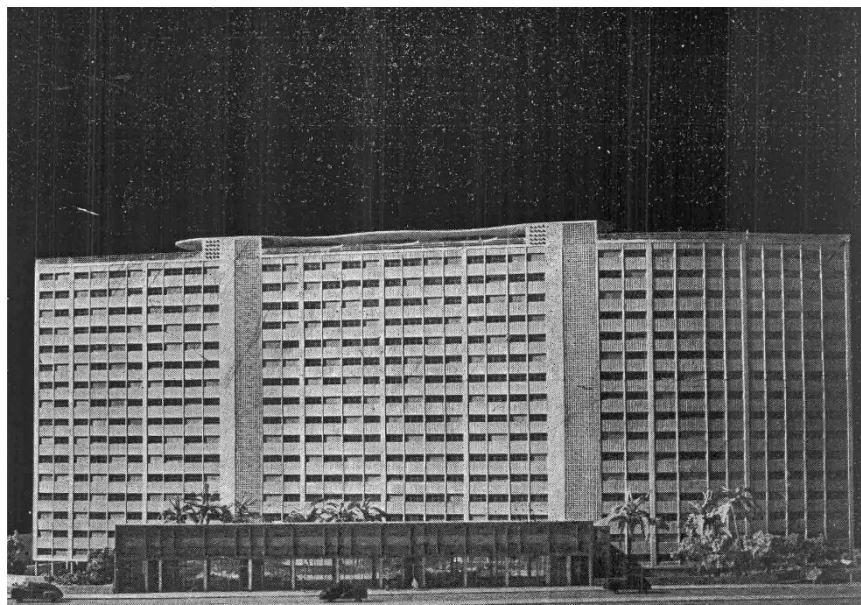
Figura 2 - Edifício Japurá, São Paulo, SP. Arquiteto Eduardo Keneese de Mello. 1945. Fonte: Cadernos de Habitação Coletiva da USP.
