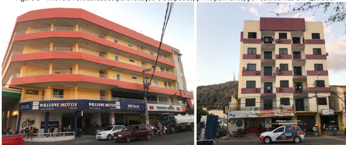
Figura 3 - Imóveis verticalizados para locação e ocupados, principalmente, por estudantes em Quixadá.
