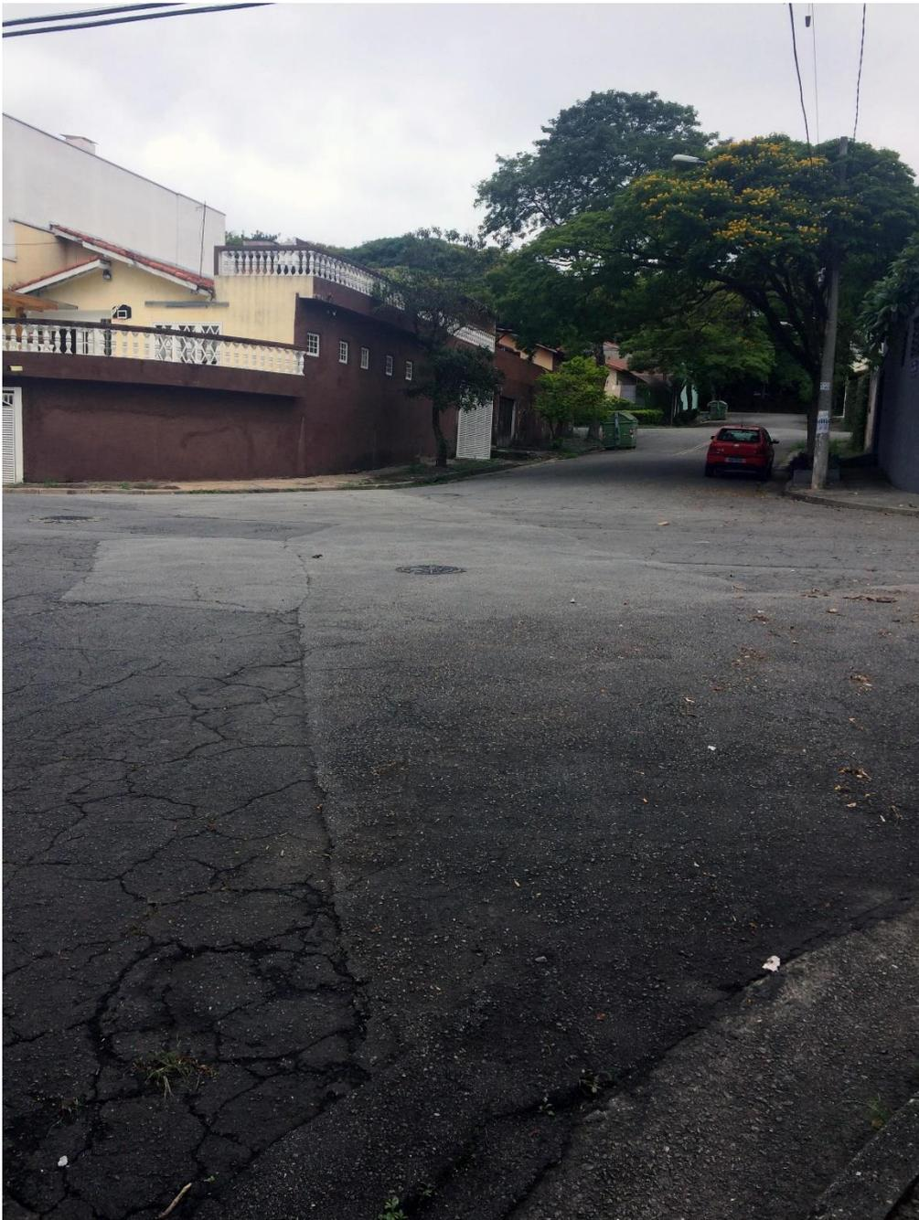
**Figura 24:** Fotografia mostra bloqueio retirado, ainda visível em remendo de asfalto.
