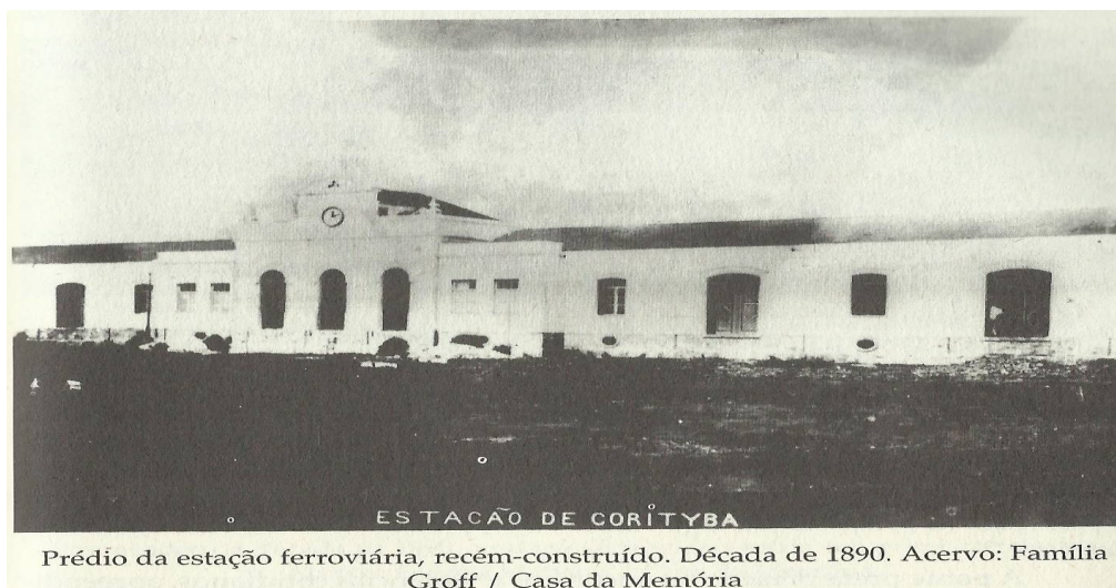
Figura 1: Estação Ferroviária Fonte: Baracho (2000)
