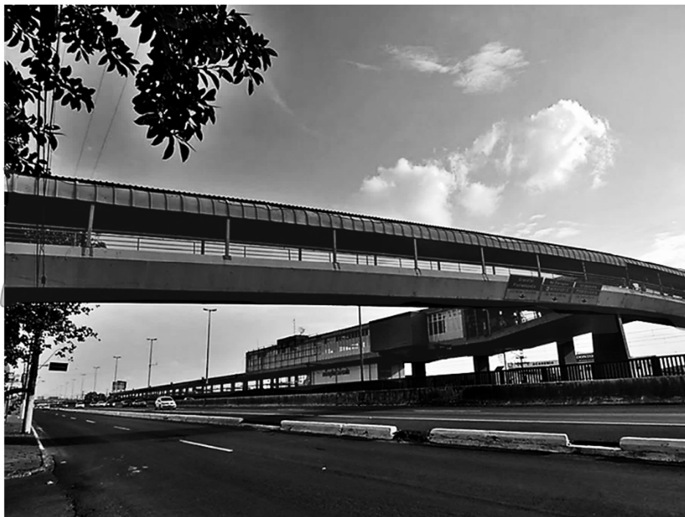
Figura 2 – Estação Niterói – Passarela elevada e área de embarque/estação junto a rodovia Br 116.
