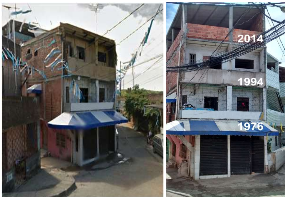
Figura 2 - Processualidade na construção da casa de Dona Vilma
