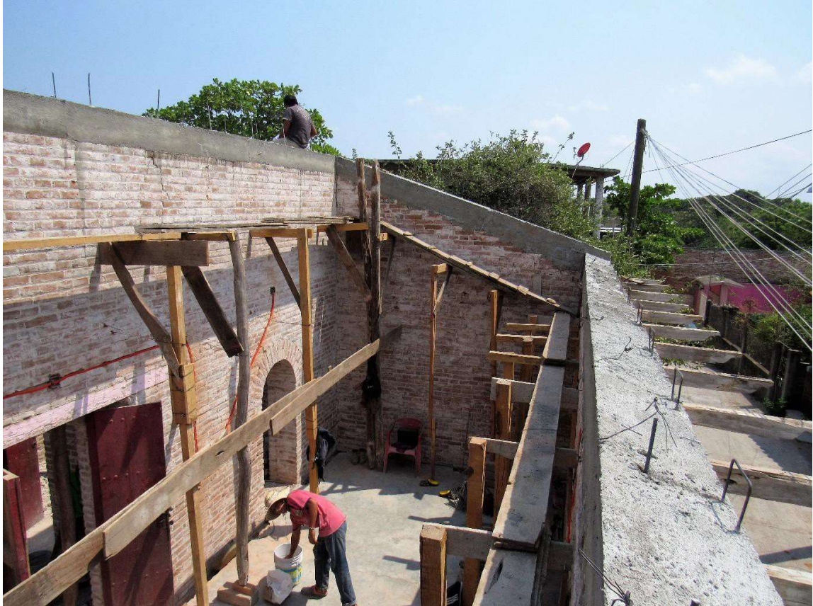
Fotografía 6. Reparación y refuerzo antisísmico de una vivienda tradicional istmeña con la asesoría de una asociación civil mexicana en Ciudad Ixtepec, Oaxaca. Fuente: propia, 2018.
