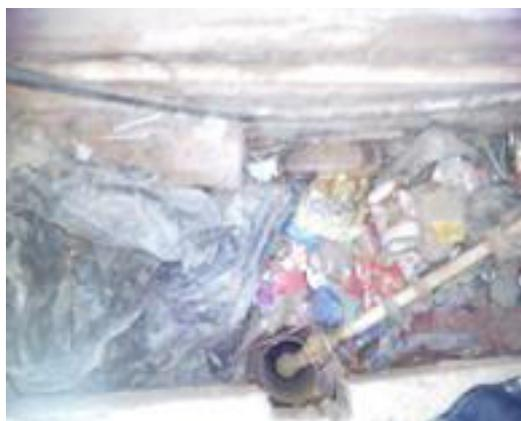
Figura 4: Poço em SAls perfurado em local totalmente inapropriado. Fonte: R7-8 PERH – Guandu (2005, p170)
