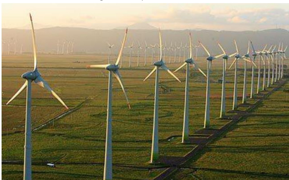
Figura 3 - Parque Eólico Osório no Brasil
