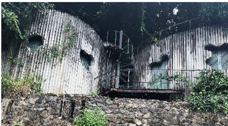
Figura 4. Vista externa do Restaurante Coaty. (Foto autoral)
