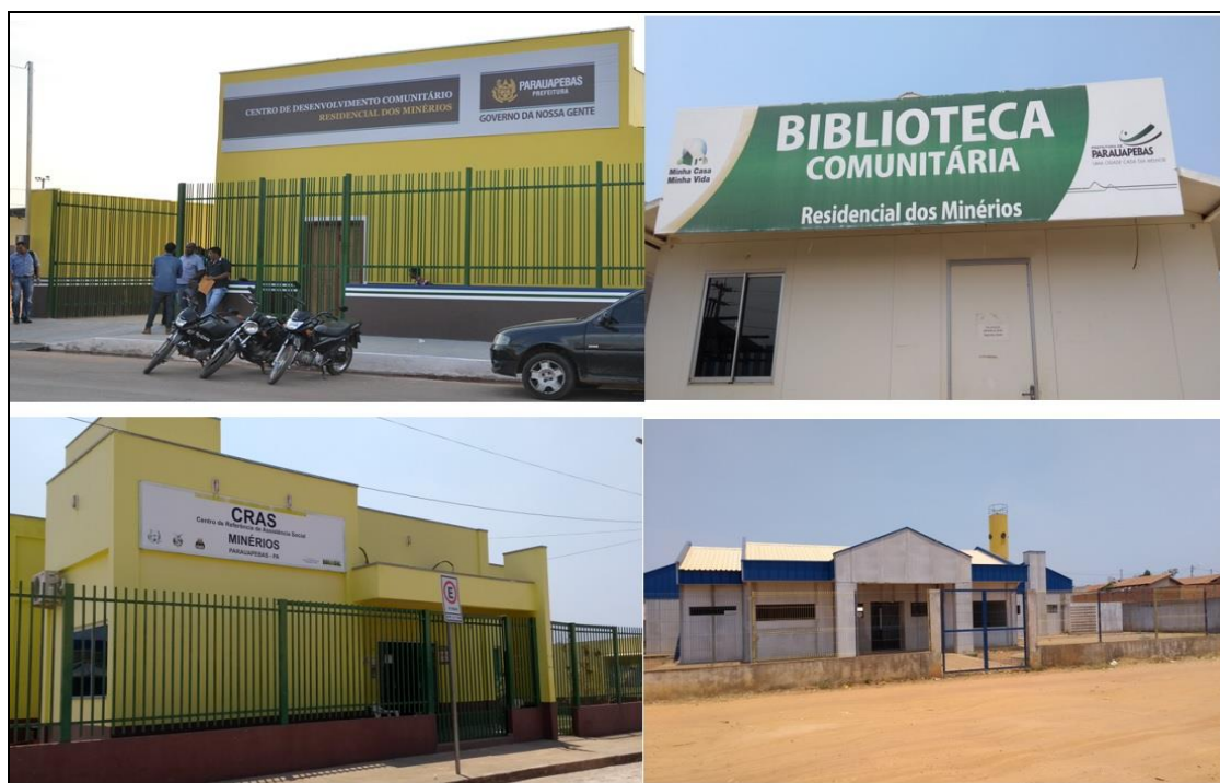
Figura 13 – Outros equipamentos públicos presentes ou em construção no Residencial dos Minérios (2018)
