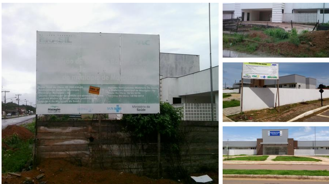
Figura 7 – Unidade Básica de Saúde em Mazagão/AP. Obra abandonada até início de 2017 e depois retomada em 2018.
