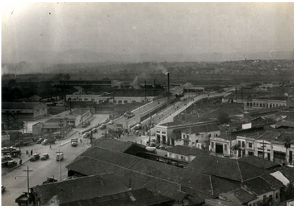
Figura 1 - Vista do Viaduto Pacaembú concluído e em funcionamento, em 1959 (Autoria não identificada). Disponível em: https://br.pinterest.com/pin/464715255289924390/?lp=true , acesso em julho de 2018.
