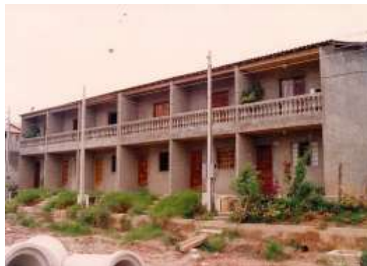
Imagem 7 – Sônia Ingá localizado no município de São Paulo. Conjunto de sobrados do programa de mutirão do município. Assessoria Técnica GAMHA. Fonte: acervo Labhab FAUUSP.
