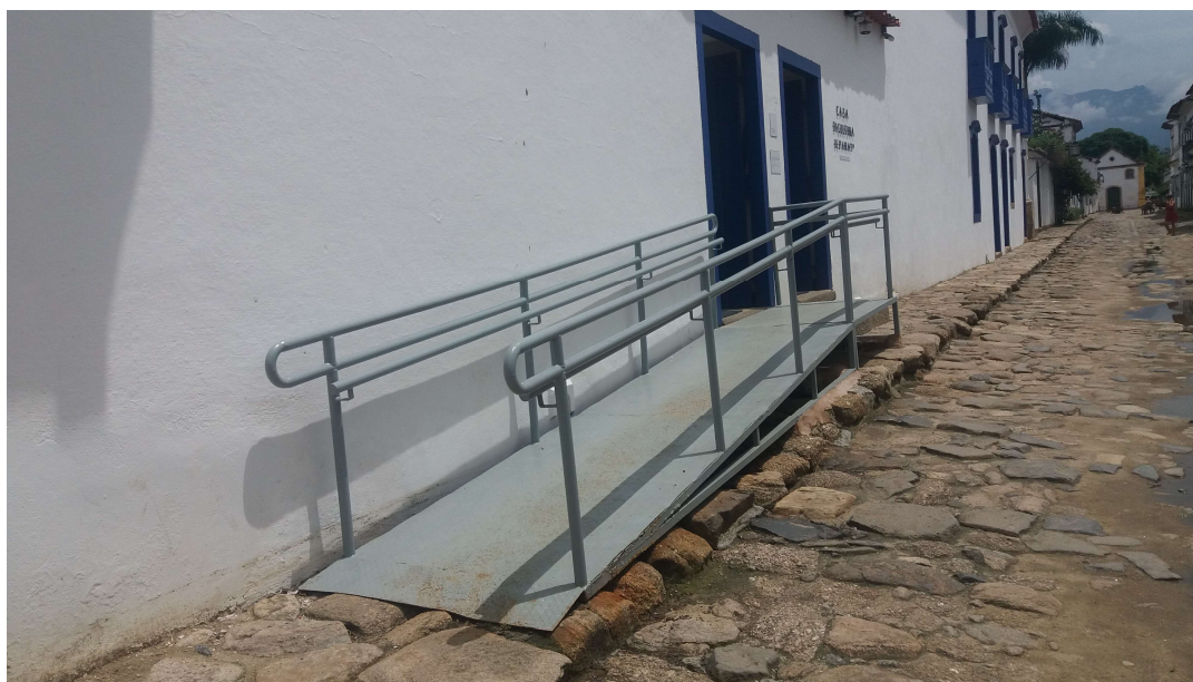
Figura 02: casa da cultura de Paraty – rampa da entrada Fonte: arquivo pessoal
