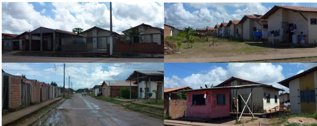
Figura 6 - Conjunto Habitacional Mestre Oscar Santos: obras avançando nos passeios públicos; ausência de divisas entre as residências; ausência de arborização urbana e passeios públicos inacessíveis, além de recorrentes problemas na rede de esgotamento sanitário; abertura de comércios locais. Fotos: acervo ATAU, 2016.
