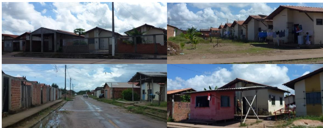
Figura 6 - Conjunto Habitacional Mestre Oscar Santos: obras avançando nos passeios públicos; ausência de divisas entre as residências; ausência de arborização urbana e passeios públicos inacessíveis, além de recorrentes problemas na rede de esgotamento sanitário; abertura de comércio locais. Fotos: acervo ATAU, 2016.
