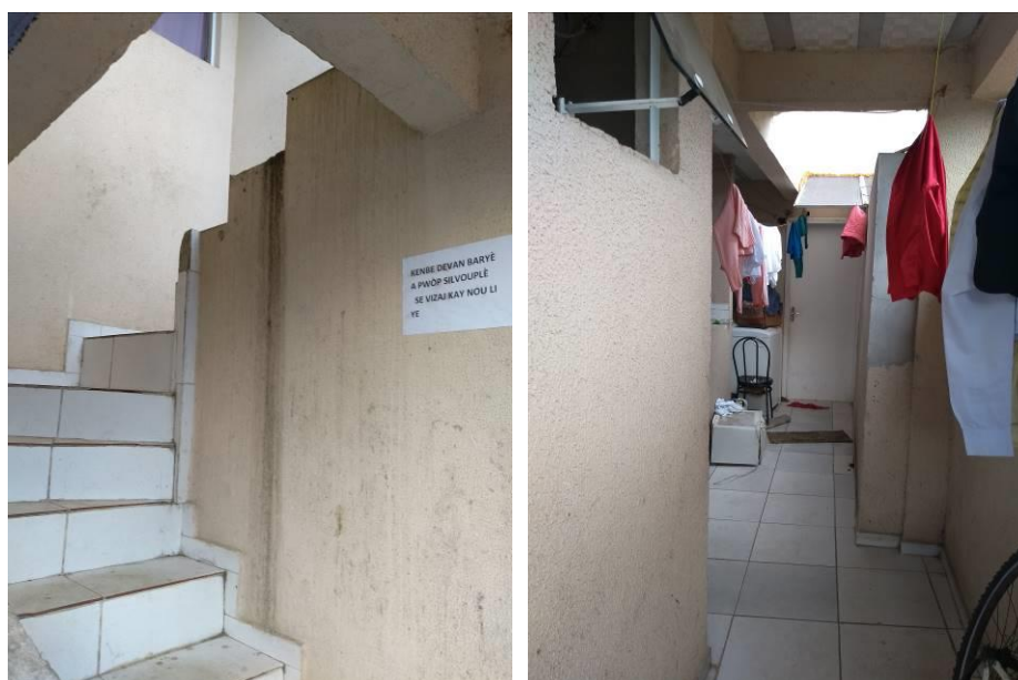
Figura 8 - Fotos do Local – Edifício de locação para haitianos Fonte: autores, acervo pessoal (2018).
