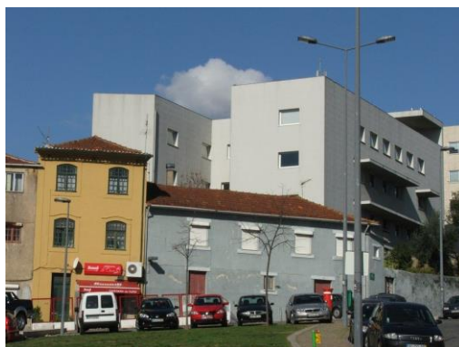
Imagem 01: Edifício de escritórios no Aleixo
