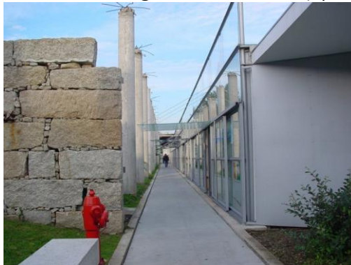
Imagem 18: Mercado de Braga – Vista interna (após reconversão)
