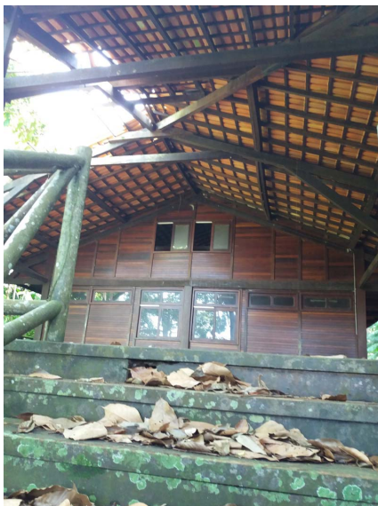
Centro de Referência sem parte da cobertura
