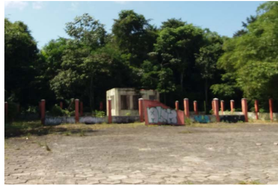
Ruínas da Guarita Av. Centenário
