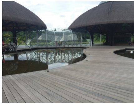
Passarela que interliga as malocas do Centro de Acolhimento
