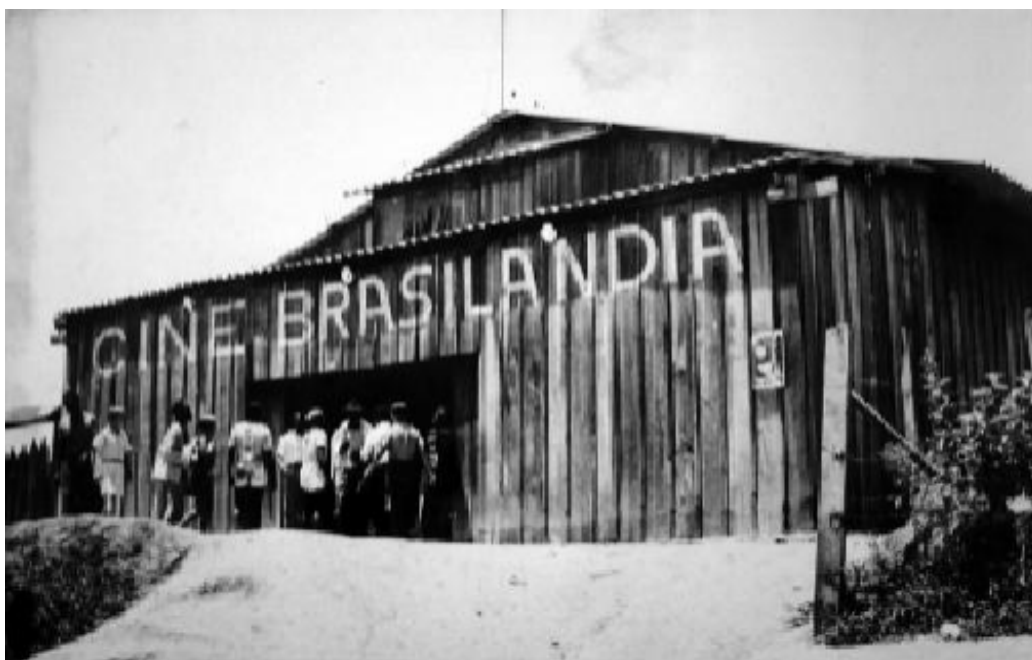
Figura 1 Cine Brasilândia, 1953. Fonte: Arquivo Multimeios Centro Cultural
