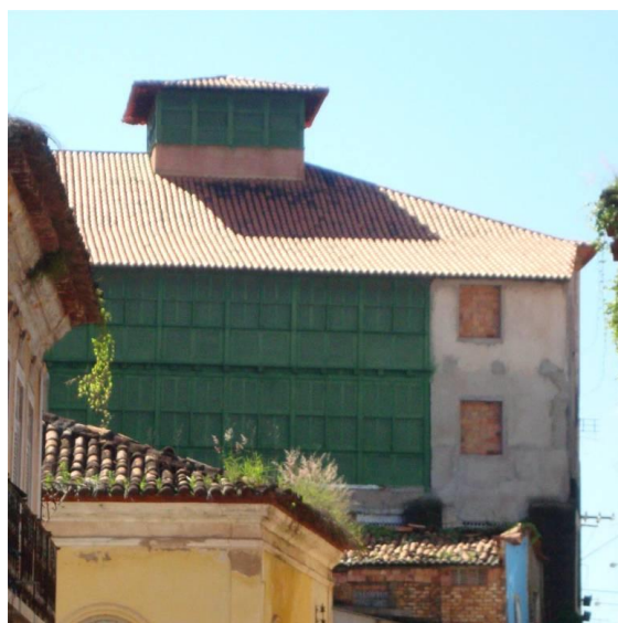
Foto 1 - Fachada posterior do sobrado situado a Praça João Lisboa, Nº37 (A Pacotilha) Fonte: Lena Carolina A. F. Ribeiro Brandão
