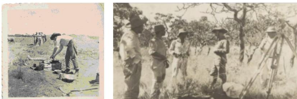
Fig. 5 - a) Colocação da pedra fundamental do município, em 1957, próximo à rodovia Brasília-Anápolis; b) Demarcação de vias da nova trama urbana no cerrado, em 1957.
