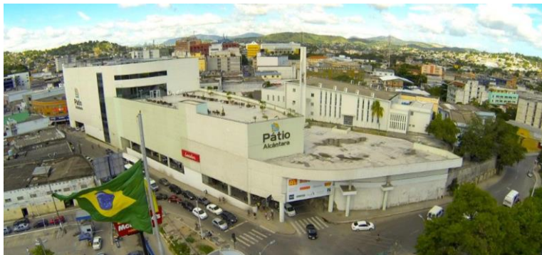
Figura 01: Shopping Pátio Alcântara obstruindo acessos, fluxos e visadas à igreja na área da antiga praça Carlos Gianelli Fonte: < http://www.dominus.com.br/shopping-ptio-alcntara >, 2015
