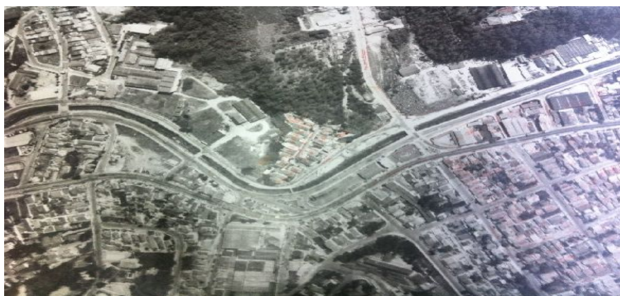
Figura 7 - Trecho do segundo trecho do Ribeirão Grande já retificado. Foto aérea, ano de 1997.
