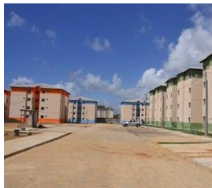
Figura 5. Residencial Ouro Preto, no bairro homônimo. Fonte: SECOM, Maceió, AL. Março 2014.
