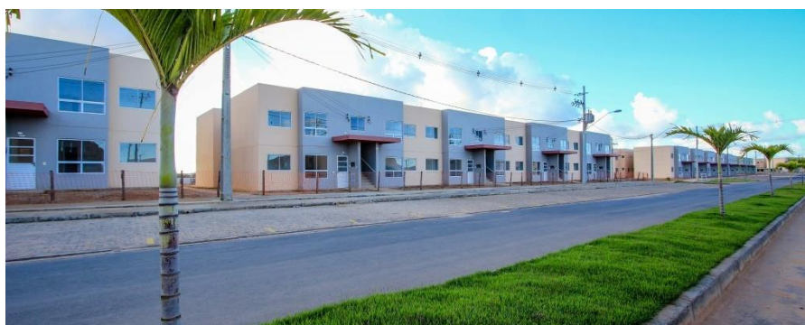
Figura 6. Modelo de edificação com 2 pavimentos adotado em seis empreendimentos em Maceió, AL. Imagem do Residencial Parque dos Caetés, no bairro Benedito Bentes. Fonte: TNH1, setembro de 2016.
