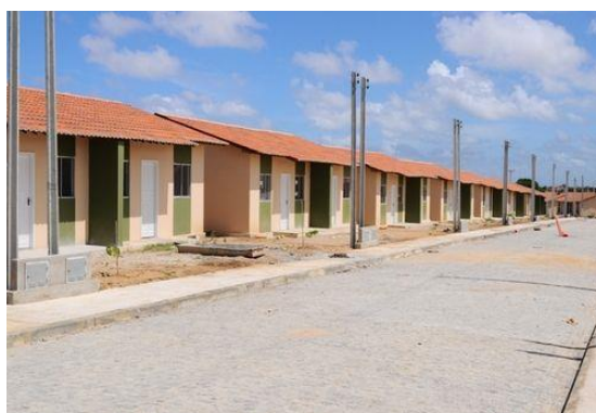
Figura 7. Tipologia das habitações do Residencial José Aprígio Vilela I, no bairro Benedito Bentes, em Maceió, AL. Fonte: SEINFRA, AL, 2011.
