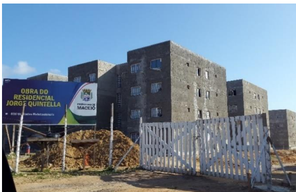
Figura 4. Residencial Jorge Quintela em construção no bairro Benedito Bentes Fonte: Arquivo pessoal, set.2015
