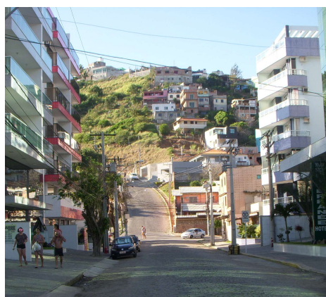
Via em Prainha, com acesso à comunidade é muito inclinada e a calçada tem degraus
