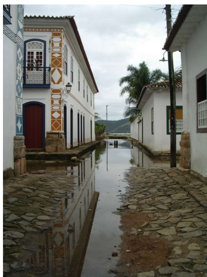
Esgotamento da maré e águas pluviais Central
