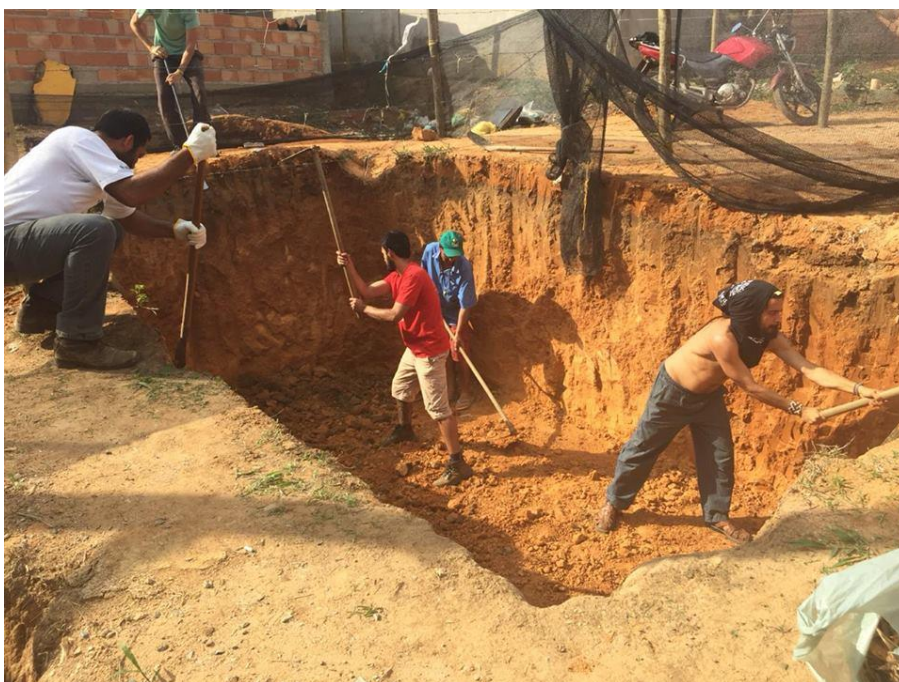
Figura 9: Mutirão para nivelamento do Tanque de Evapotranspiração.
