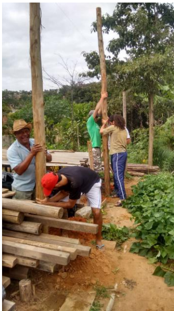
Figura 3: Mutirão de fixação da estrutura. Fonte: Foto de arquivo pessoal.
