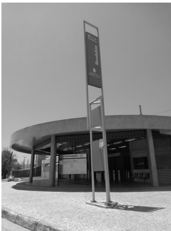
Imagem 05: Estação Mondubim do Metrofor | agosto/2016 (Fonte: Autora)
