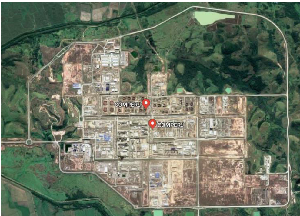
Figura 06 – Complexo Petroquímico do Rio de Janeiro
