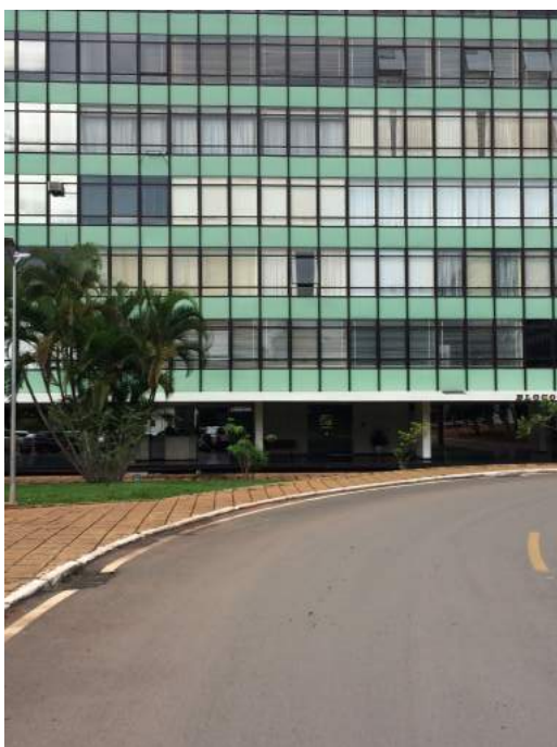
Fachada do Bloco E SQS 308 Foto do autor
