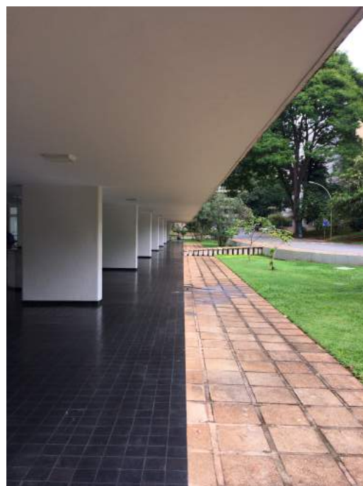
Pilotis do Bloco E SQS 308 Foto do autor
