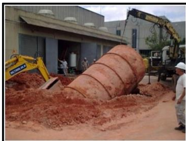
Figura 4: Remoção de Tanque enterrado
