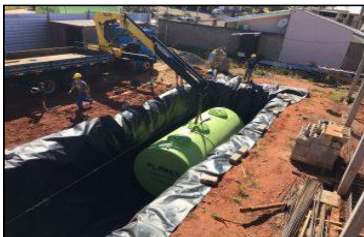
Figura 10: Impermeabilização de cava de tanque de armazenamento de combustível.
