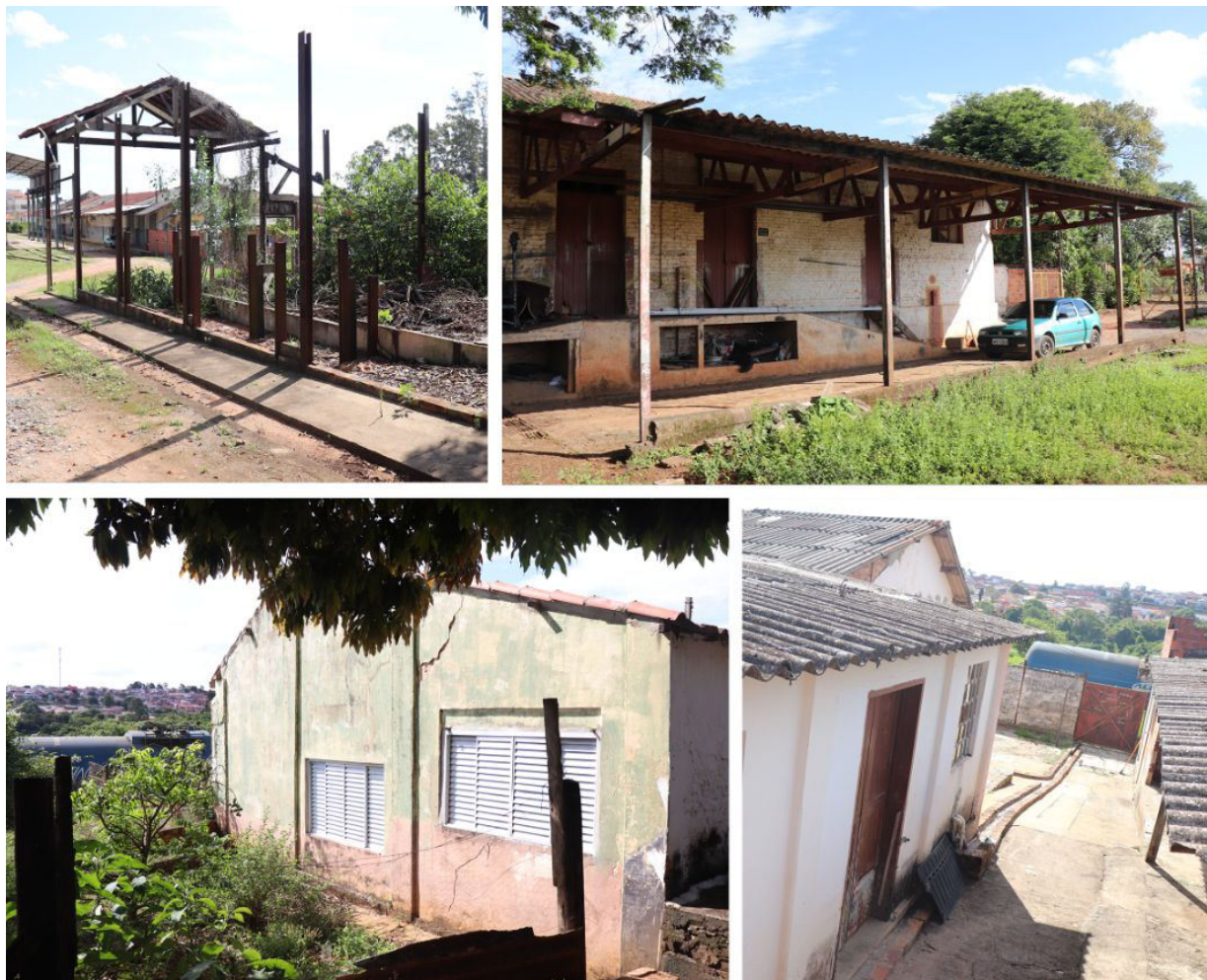
Figura 5 - Vista da Serralheria e administrativos
