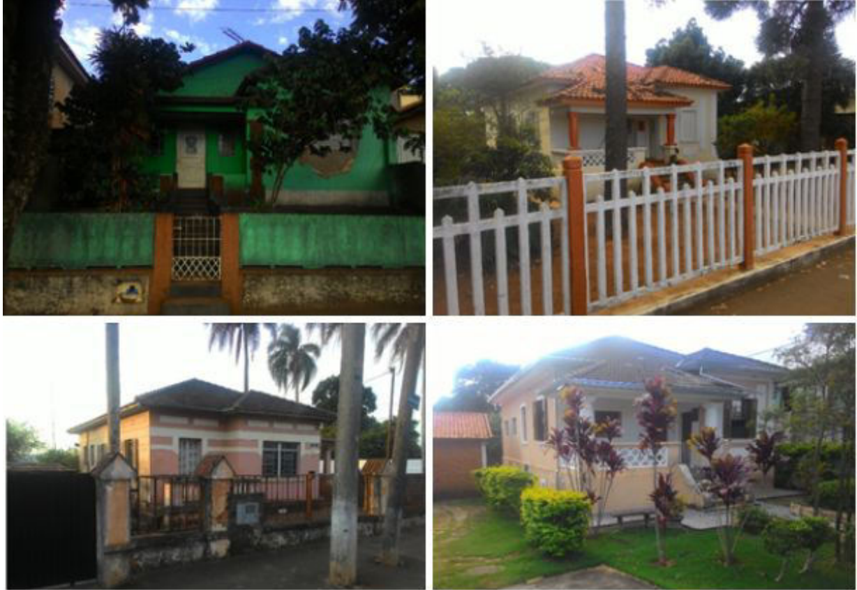
Figura 5 - Vista de alguns exemplares de Residências Ferroviárias
