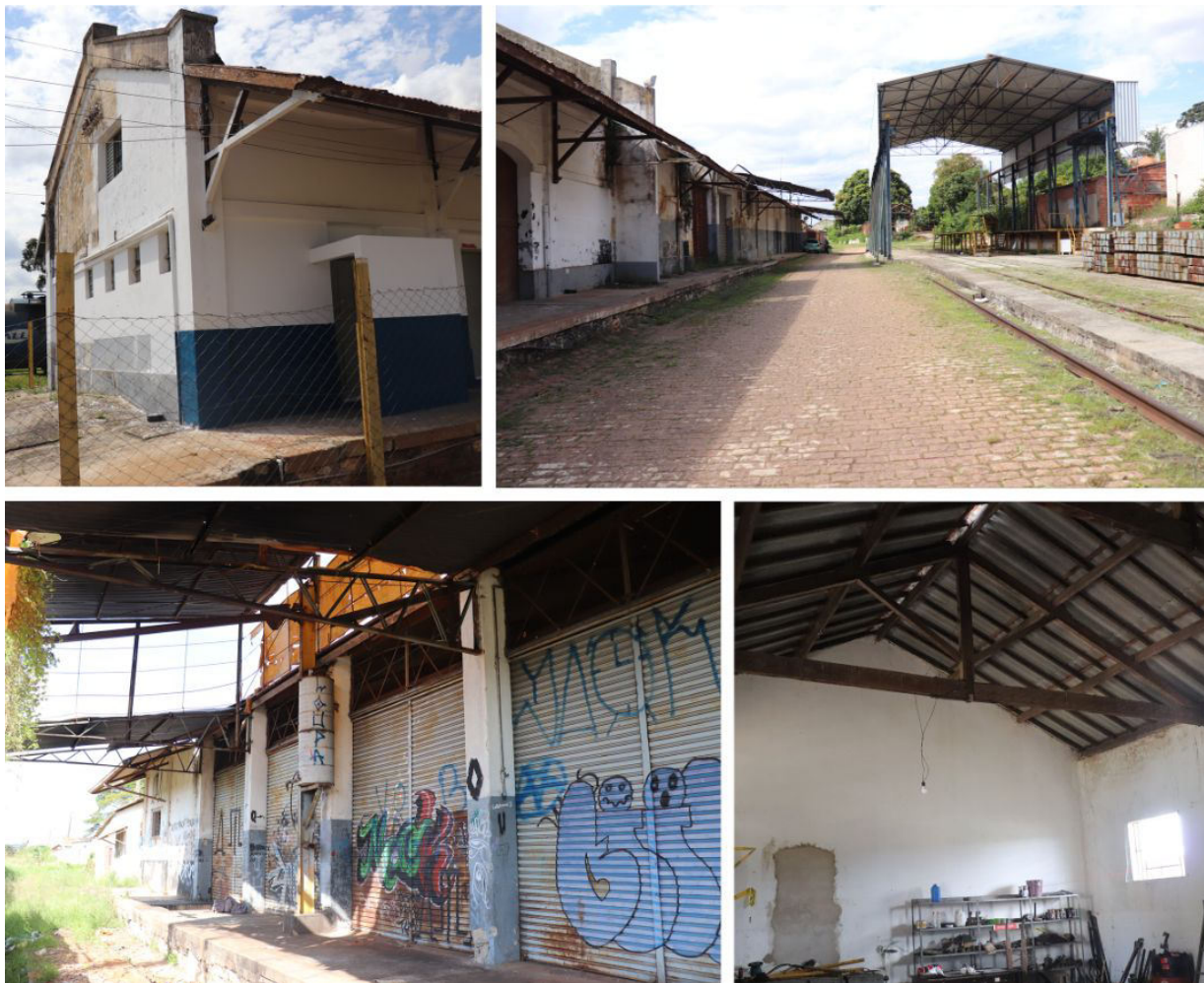
Figura 4 - Vista dos Armazéns e oficina
