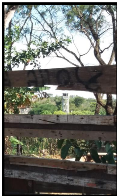
Figura 10: Vista da guarita do Jardim Europa
