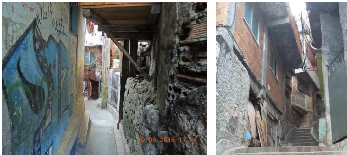
Figuras 11 e 12. Fotos com exemplos de sacadas cobrindo a circulação externa
