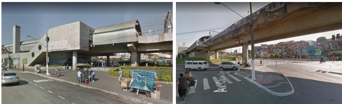
Figura 12 Estação Capão Redondo da linha 5-Lilás na zona sul de São Paulo. Imagens do Google Maps, 11 set. 2018.
