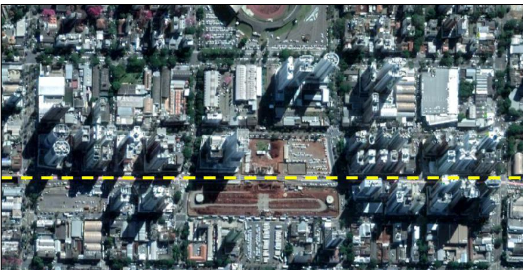
Figura 17: A transformação do pátio de manobras da ferrovia em 1980, 2009 e 2018. Em pontilhado a linha férrea (em nível e rebaixada). Fonte: Acervo do Laboratório de Geoprocessamento, Departamento de Engenharia Civil-Universidade Estadual de Maringá e Google Earth.
