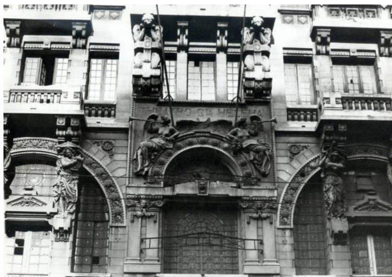
Figura 7: Fachada principal, detalhes da ornamentação com relevos em argamassa e balaústres em cimento.
