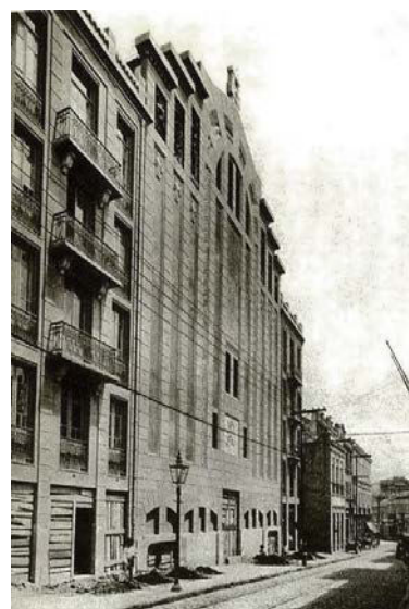
Figura 8: Fachada dos Fundos do Palacete Santa Helena, na antiga Rua Onze de Agosto.
