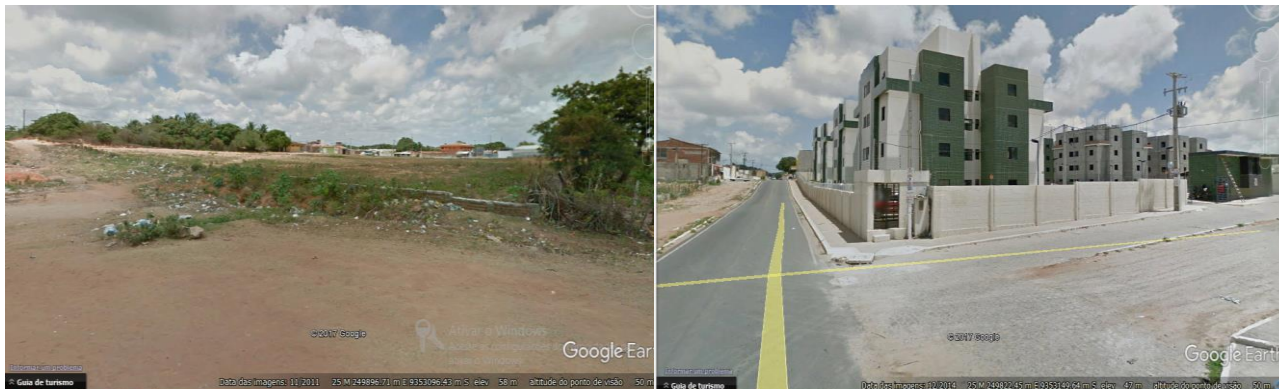
Imagem 4: Vista em 2011 e em 2014 do mesmo empreendimento.
