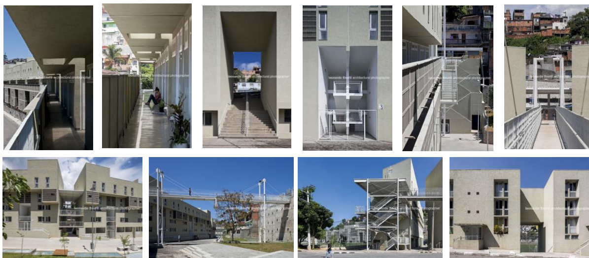
Figura 13: Fotos dos elementos de circulação, vertical e horizontal, do conjunto Santo Amaro V. Fonte: Leonardo Finoti - Architectural Photographer.
