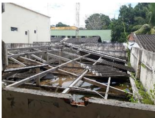
Imagens 25 a 27 - Exemplo de imóvel em processo de destinação, porém com benfeitoria precária, localizado no Acre. Fonte: SPU, 2018.
