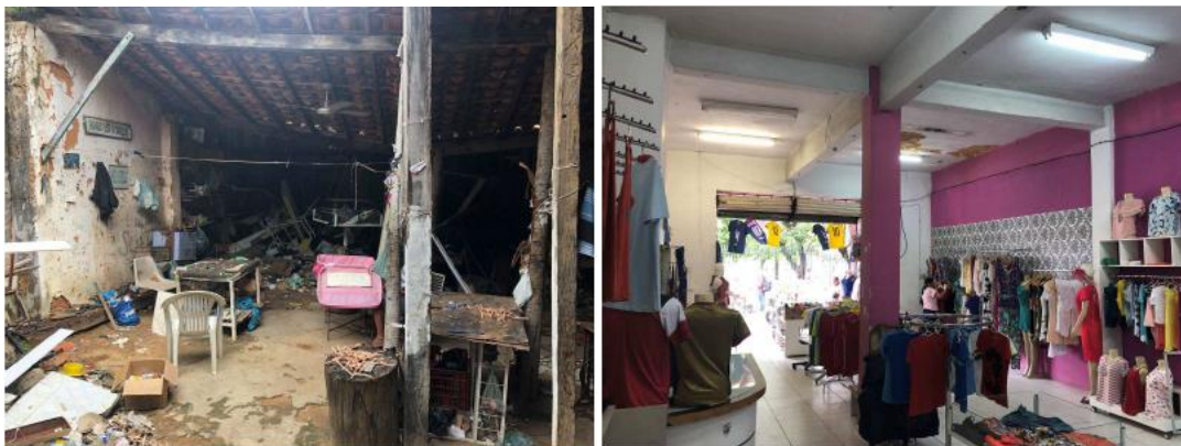
Imagens 17 a 20 - Exemplo de imóvel com ocupação irregular e precário, localizado em Teresina/PI. Imóvel cedido ao Governo do Estado. Fonte: SPU, 2018.
