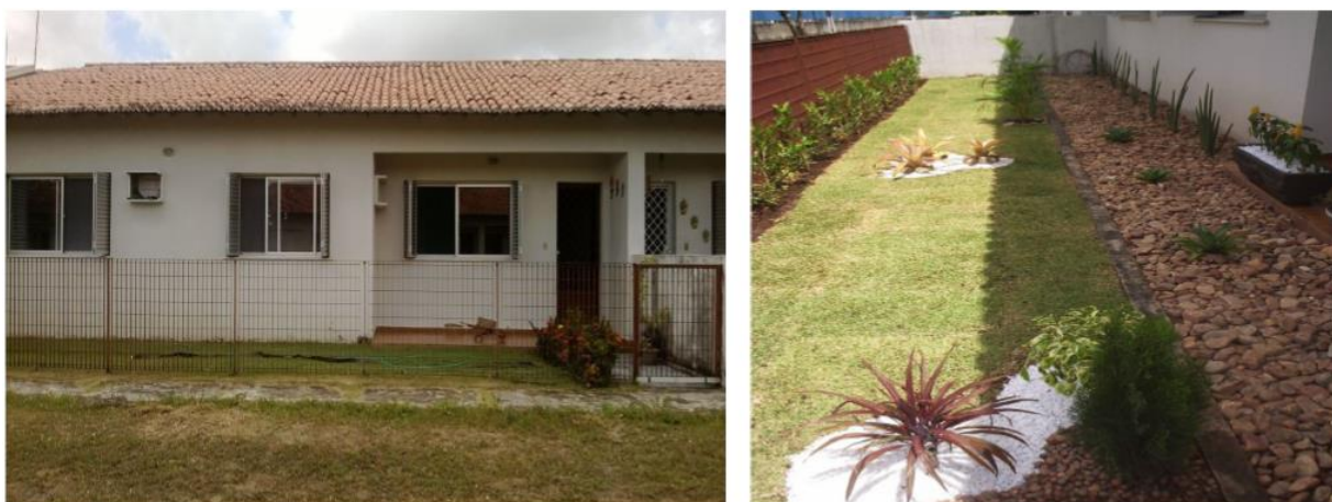
Figura 11 e 12 – Vista Frontal e Lateral do Tipo de PNR do CHAS
