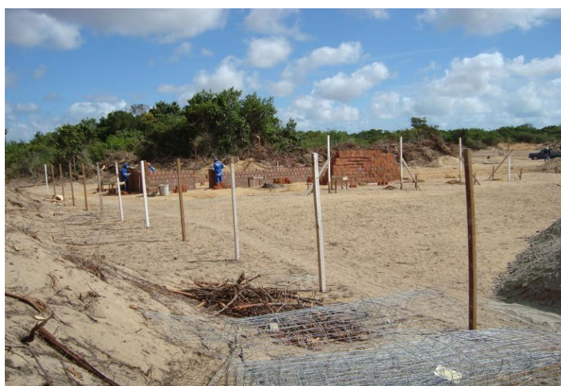
Figura 16 – Construção da Vila Militar Albatroz
