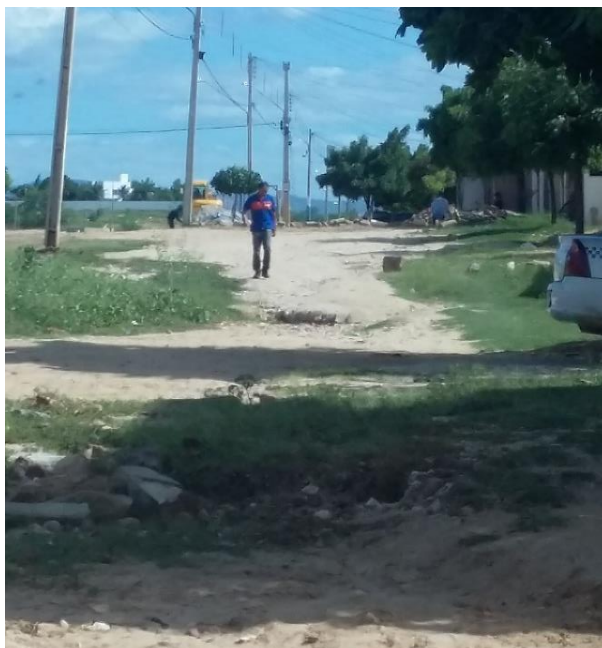
Figura 10. Vias do Ato da Tubiba sem pavimentação.
