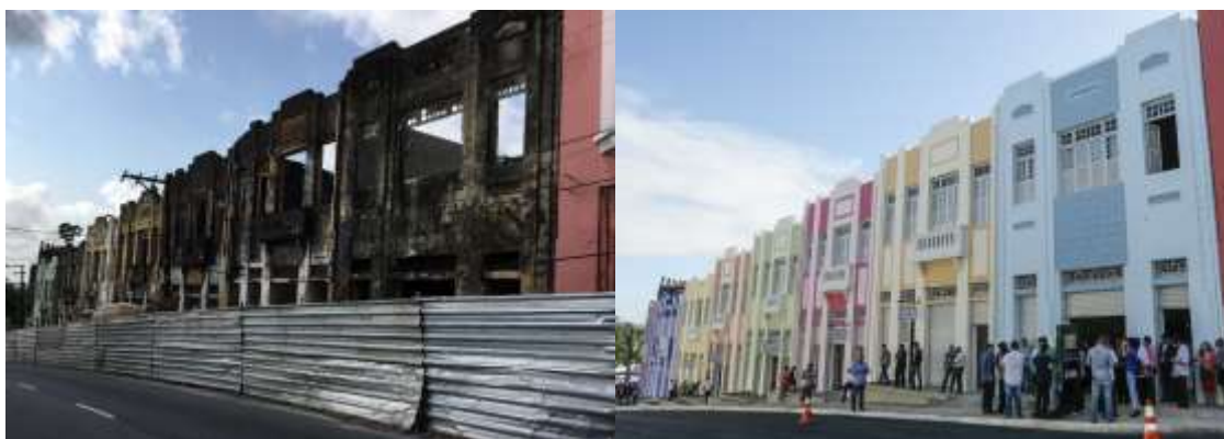
Figura 05: Vila Sanhauá. Os oito casarões na Av. João Suassuna, Varadouro – João Pessoa/PB. A situação anterior e após a obra de revitalização, no dia da entrega dos imóveis aos proprietários.
