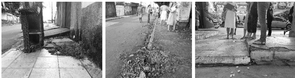
Figura 26, 27 e 28. Mobiliário urbano como barreira de fluxo, obstruções nos passeios e rampa fora do padrão.
