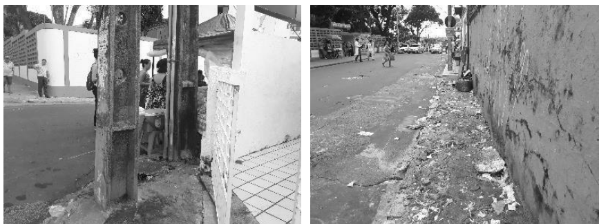
Figura 18 e 19. Rampa para carro e estrutura do passeio comprometida.
