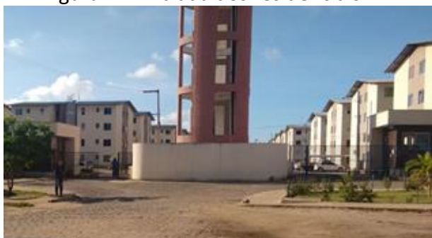
Figura 4 – Entrada dos residenciais
