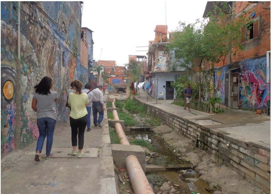
Figura 8: Construção do canal e a separação a montante do córrego Canguaras na favela Vila Flávia, São Paulo. Fonte: Campos (2015). Figura 9: Foto do córrego e a tubulação que conduz a drenagem de águas pluviais em paralelo ao curso d'água. Fonte: PSA, 2018.
