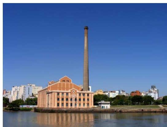
Figura 4 – Vista da Usina do Gasômetro, Porto Alegre - RS, Brasil.
