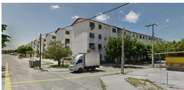
Figura 21 – Vista do Conjunto Habitacional Dom Hélder Câmara.
