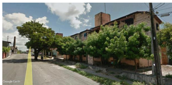
Figura 22 – Vista do Conjunto Habitacional Alves de Lima.
