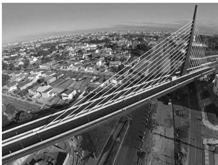
Figura 2 - Viaduto Francisco H. dos Santos sobre a Av. Comendador Franco, em Curitiba – PR
