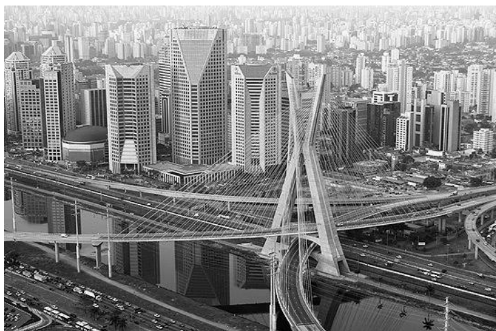
Figura 3 – Viaduto estaiado localizado no centro da cidade de São Paulo
