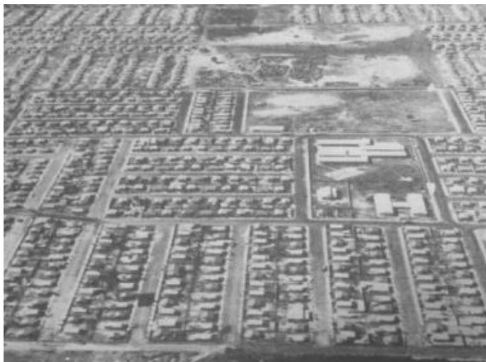
Figura 7: Imagem aérea do CPA I e, ao fundo, movimento de terra para implantação das demais etapas. Fonte: Freire (1997, p. 180).
