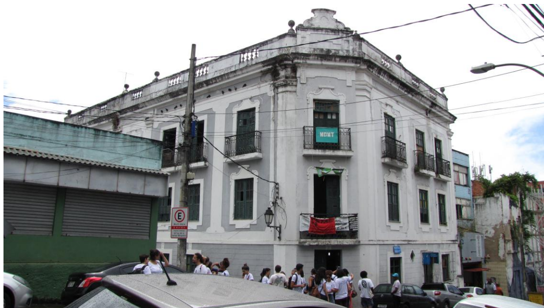
Fig. 1: Fachada do Casarão nº18. Fonte: Equipe Ladeira da Praça, RAU+E UFBA (2018).
